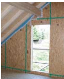
Während der Vorfertigung einge-brachte Einblasöffnungen
