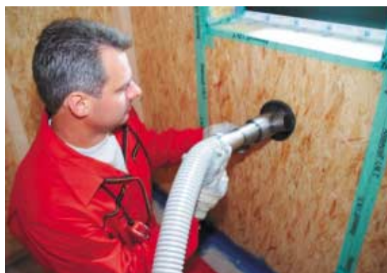
Ausblasen eines Außenwandgefaches
