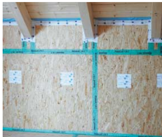
Luftdichte Abklebung der Einblasöffnungen
